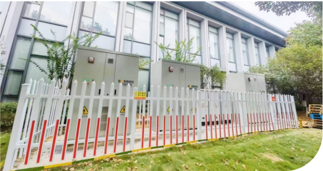
浙江某新能源科技有限公司 300KW/696KWh储能系统 风冷户外柜储能产品
