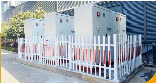
杭州某科技有限公司 600KW/1392KWh储能系统 风冷户外柜储能产品
