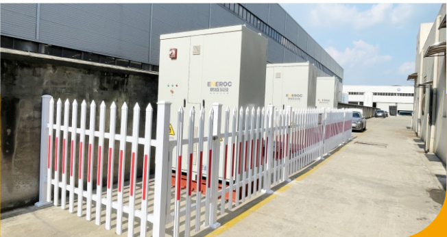
杭州某气体有限公司 300KW/525KWh储能系统 风冷户外柜储能产品
