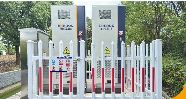
杭州某机械制造有限公司 200kW/430kWh 液冷户外柜储能产品
