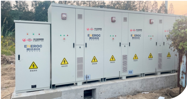
江苏某电力工程技术有限公司 500KW/1046KWh储能系统 风冷户外柜储能产品
