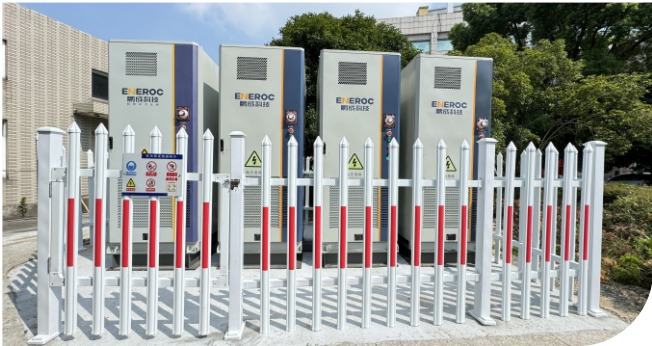
杭州某服饰有限公司 400kW/860kWh 液冷户外柜储能产品
